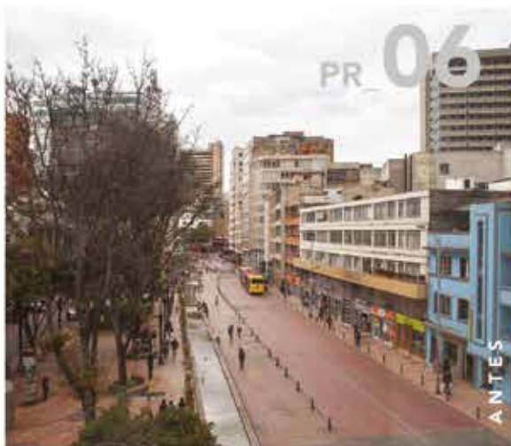
Eje Ambiental. Mantenimiento y restauración zonas Peatonales. Mantenimiento de la malla vial.
