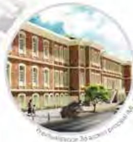
Pr_07 Proyecto de restauración Hospital Materno Infantil.
