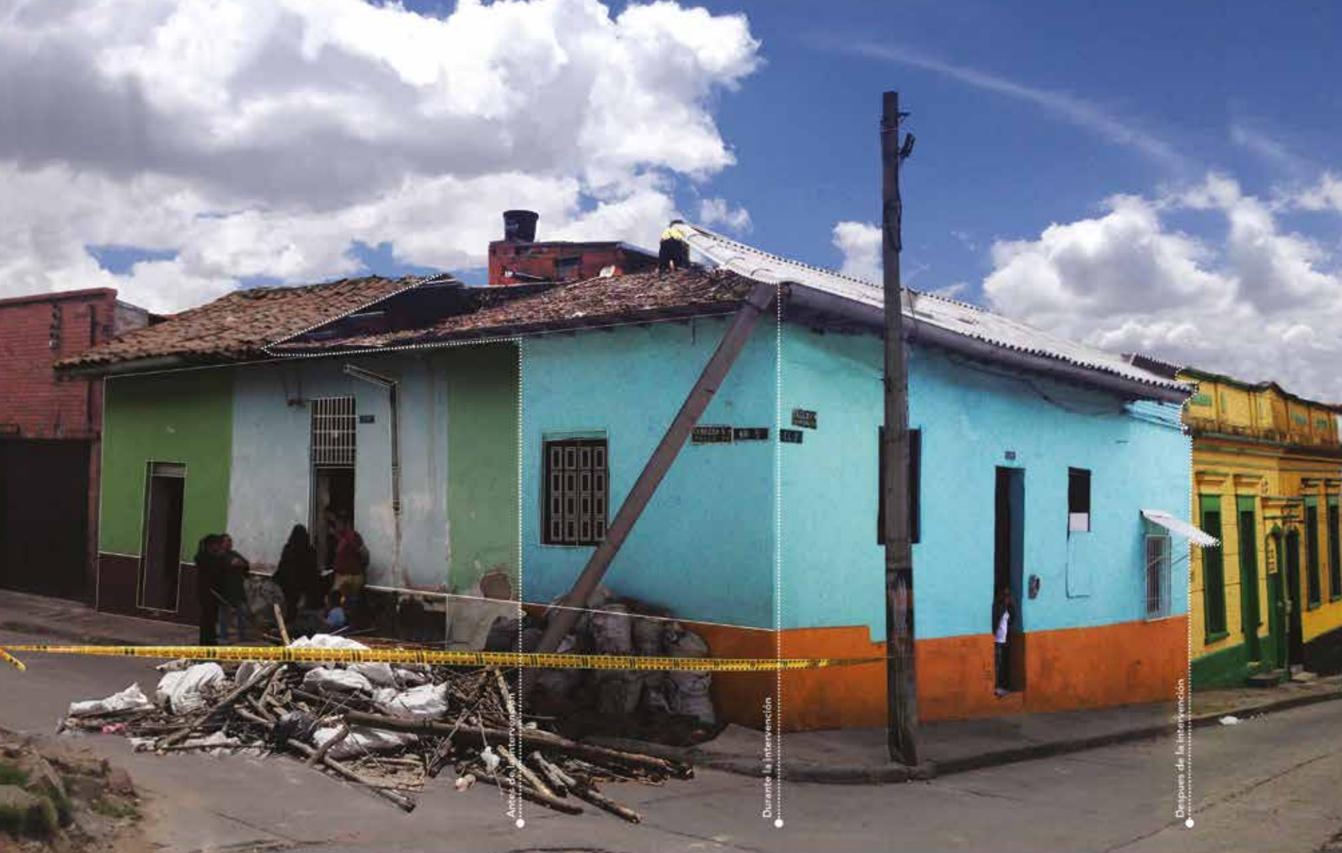
Mejoramiento de vivienda barrio las Cruces - IDPC 2015.
